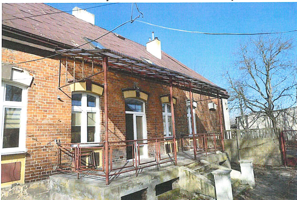
8. Fasada od strony ogrodu. Widoczny metalowy dach nad tarasem.
