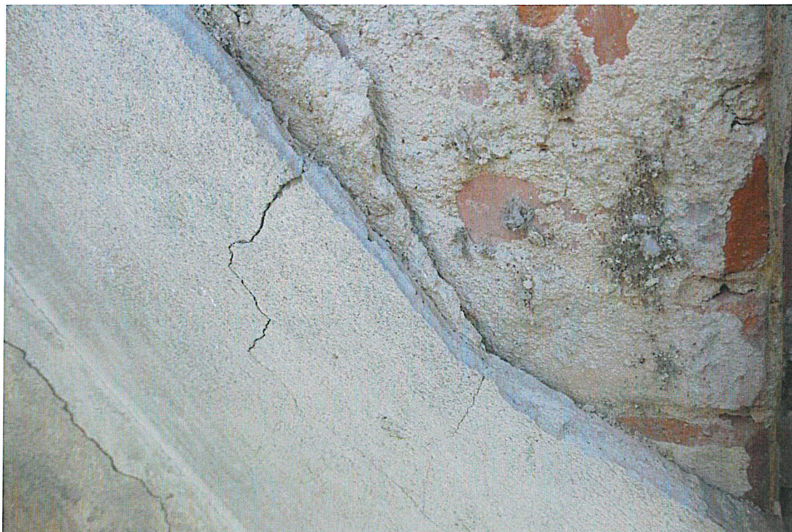
9. Fasada od strony ogrodu. Narożny pilaster. Widoczny tynk pierwotny i cementowe łąty.
