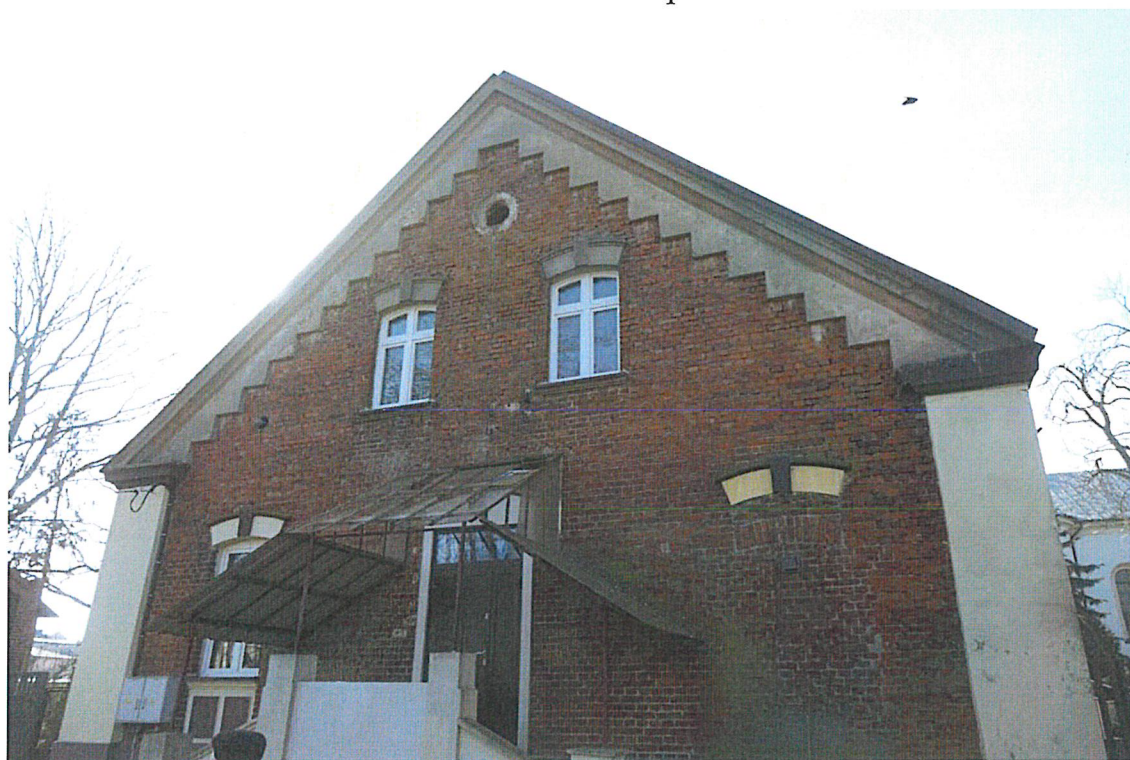
5. Fasada szczytowa. Widoczny prowizoryczny daszek nad wejściem.
