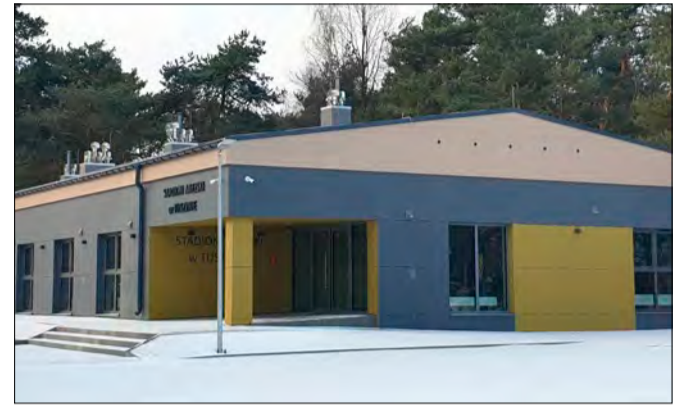
3: Nowy budynek na Stadionie Miejskim
