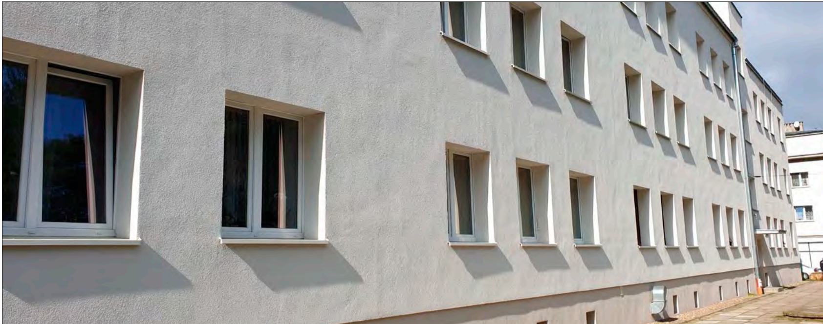
Termomodernizacja bloków w Tuszynku
