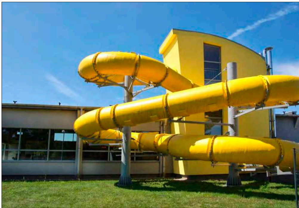
Termomodernizacja Pływalni Oceanik
