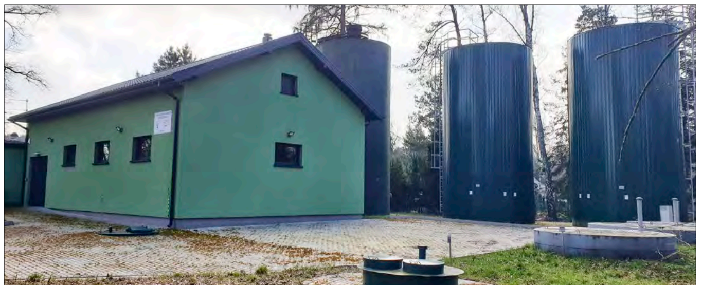
Stacja uzdatniania wody w Rydzynkach.
