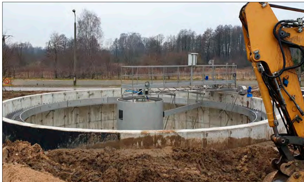
5: Modernizacja Oczyszczalni Ścieków w Tuszynie
